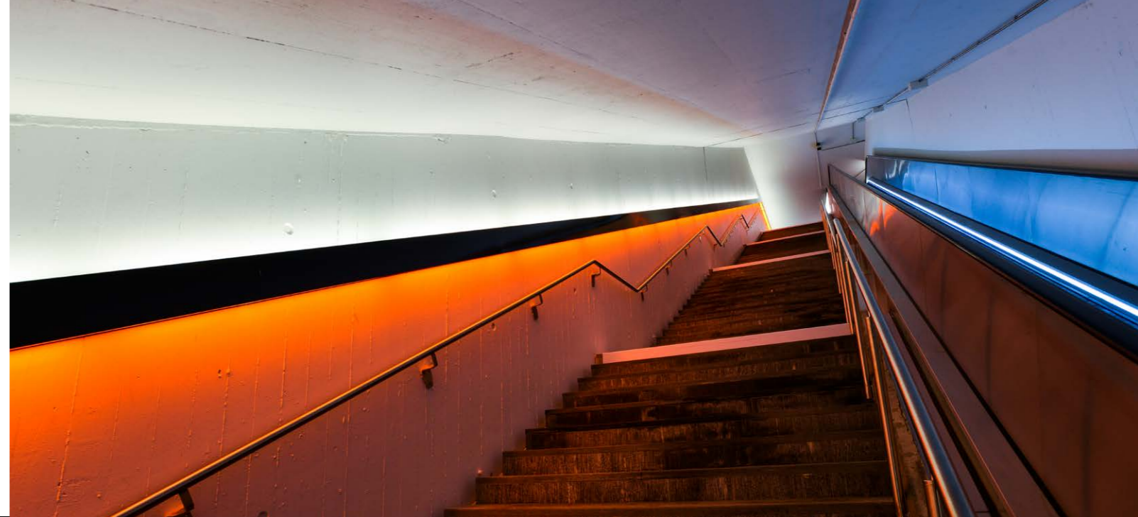
Wand abgelösten, durchgehenden Lichtband, das nach oben weisses, nach unten farbiges Licht abstrahlt. Die Lichtfarben sind bei allen 3 Haltestellen gleich, jeweils im stadtseitigen Zugang in grün, stadtauswärts in orange. Beim Aussteigen auf der Haltestelle kann man von weitem die beiden Portale mit den komplementären Lichtfarben erkennen.
