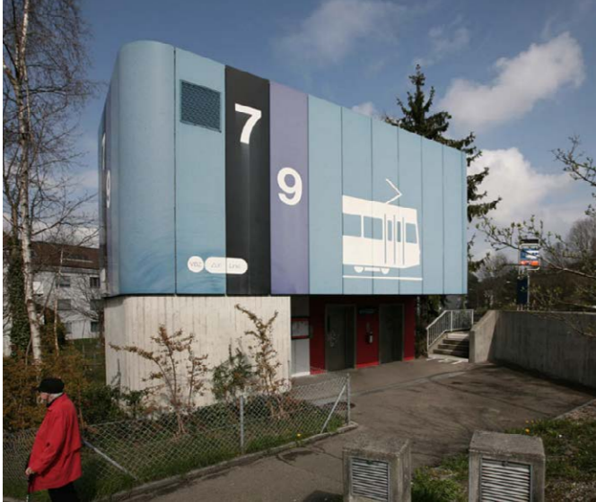
Das grafische Erscheinungsbild der Lifttürme verlangt nach einer Aktualisierung, und die Oberfläche der Metalltafeln weist viele Ausblühungen, Verfärbungen und verrostete Stellen auf.
