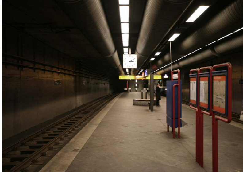
Schalldämmelemente in Form von Rohren drücken den Raum unnötig, verschatten die Wand- und Deckenbereiche und machen so den Raum schwer erfassbar.
