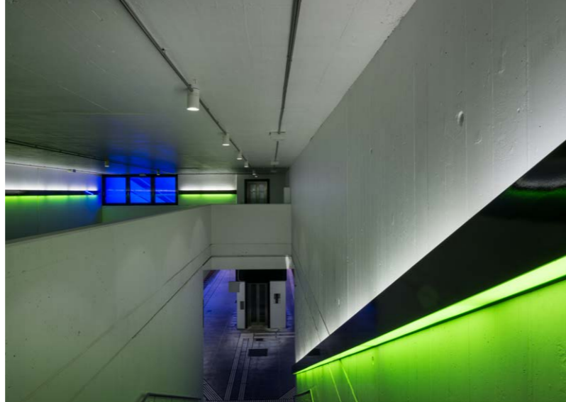
Stadteinwärts sind die Räume mit grünem Licht, stadtauswärts mit orangem Licht akzentuiert. So kann man sich bereits auf der Haltestelle orientieren.
